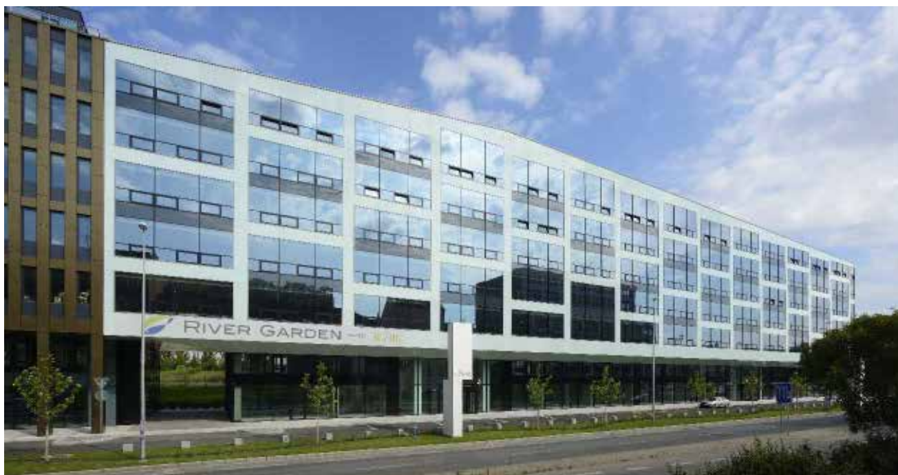
1 Východní část objektu opláštěná skleněnými panely; v popředí jeden z průchodů do zahradně upraveného vnitrobloku.
