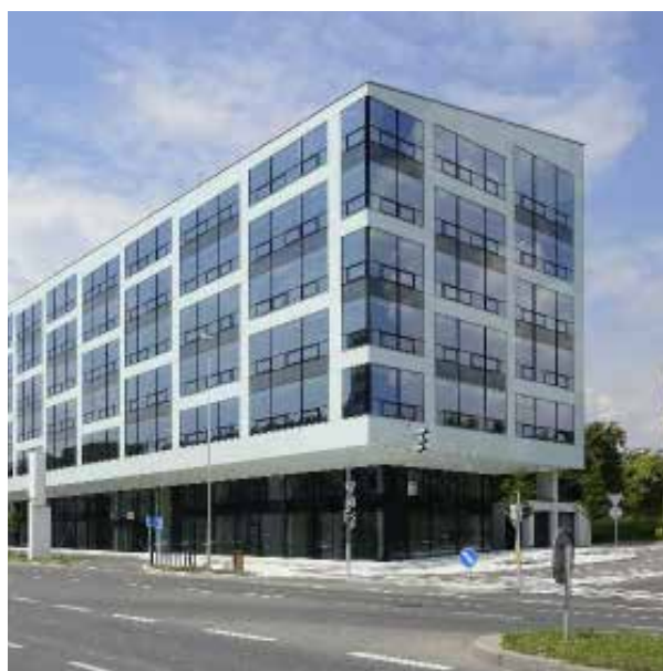
3 Jihovýchodní nároží; tvar objektu je ovlivněn snahou nezastínit budoucí sousední objekty.
