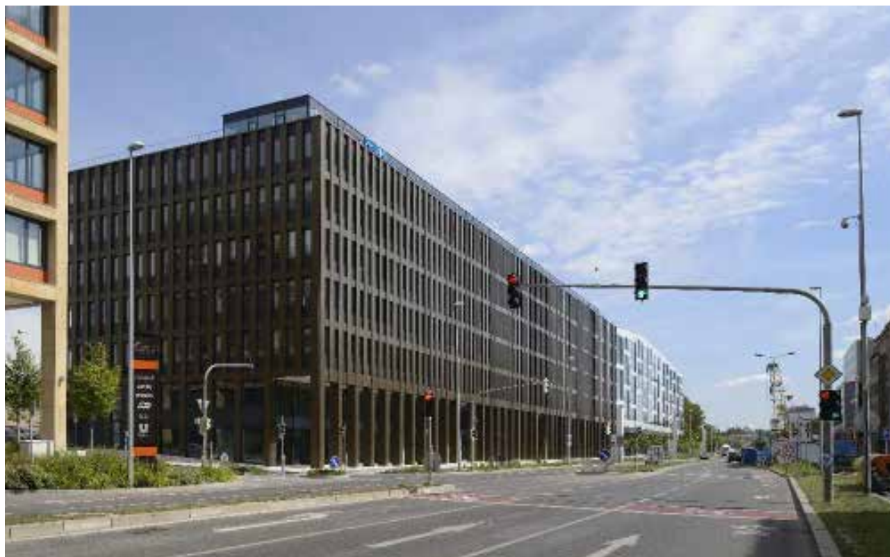
2 Pohled na západní část objektu se střídě členěnou fasádou s bronzovým obkladem.
