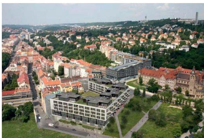
5 Vizualizace prvních dvou fází projektu Sacre Coeur – Rezidencí I a II a urbanistických souvislostí.
