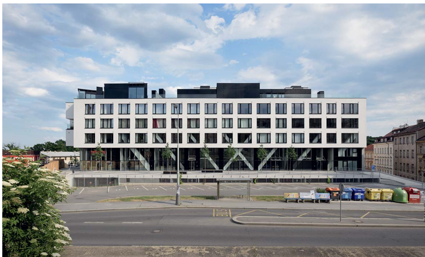
1 Rezidence Sacre Coeur II se včleňuje do městské blokové zástavby na pražském Smíchově, za prosklenou fasádou však skrývá masivní mostní konstrukci rozkročenou nad tubusy Strahovského tunelu.
