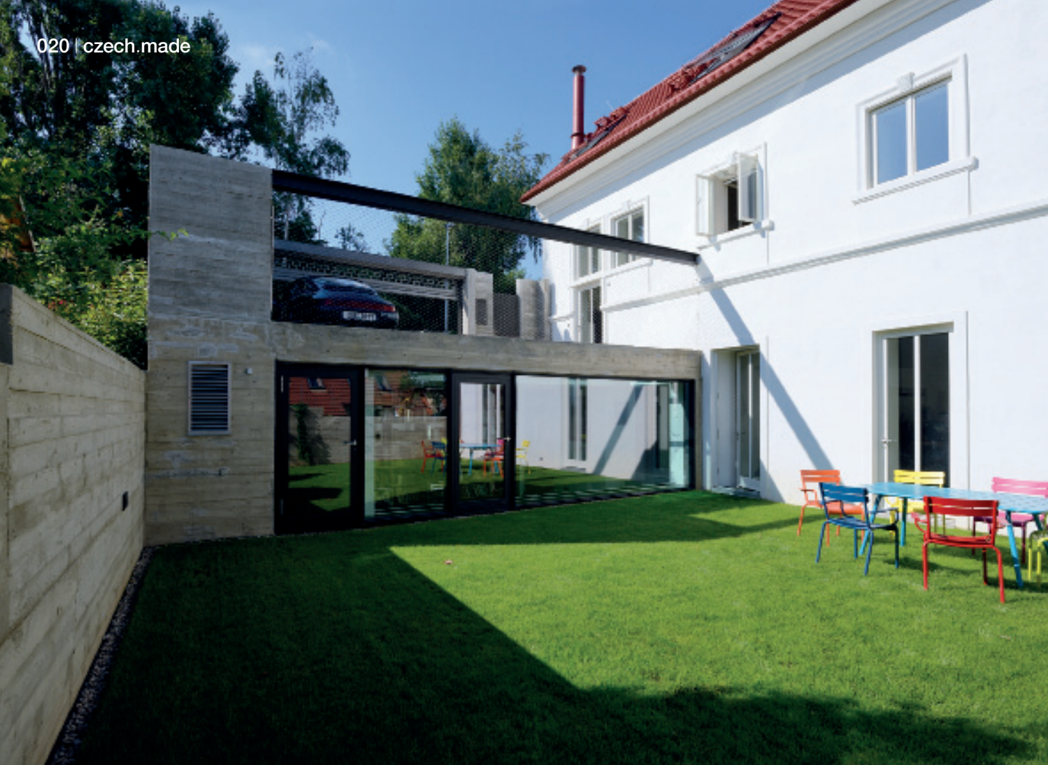
Nahoře: Exteriéru přístavby dominuje hrubý beton, na jehož povrchu nalezneme otisky dřevěného bednění, a rozsáhlá prosklená fasáda, která vizuálně i funkčně komunikuje se zahradou. Dole: Nejvyšší patro domu skrývá intimní část pro jeho obyvatele. Najdeme zde ložnici, tři dětské pokoje, pracovnu nebo hostinský pokoj. Zárubné dveří architekti vytvarovali do originální geometrické formy.
